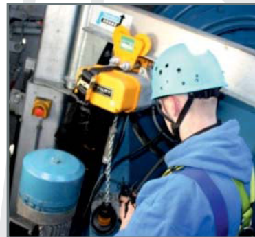
Überprüfung Krananlage / technische Hebezeuge inspection crane / lifting equipment technical
