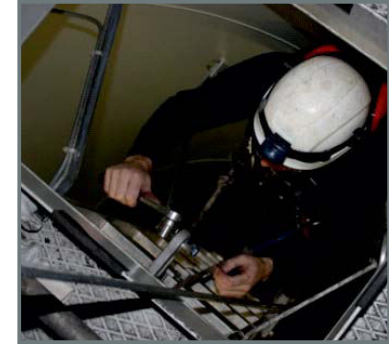
Nachrüstung Steigschutz gem. EN 353-1 installing climbing protection acc. system 353-1
